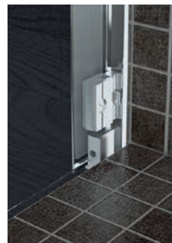
Element mocujący profil skróconej ścianki bocznej
